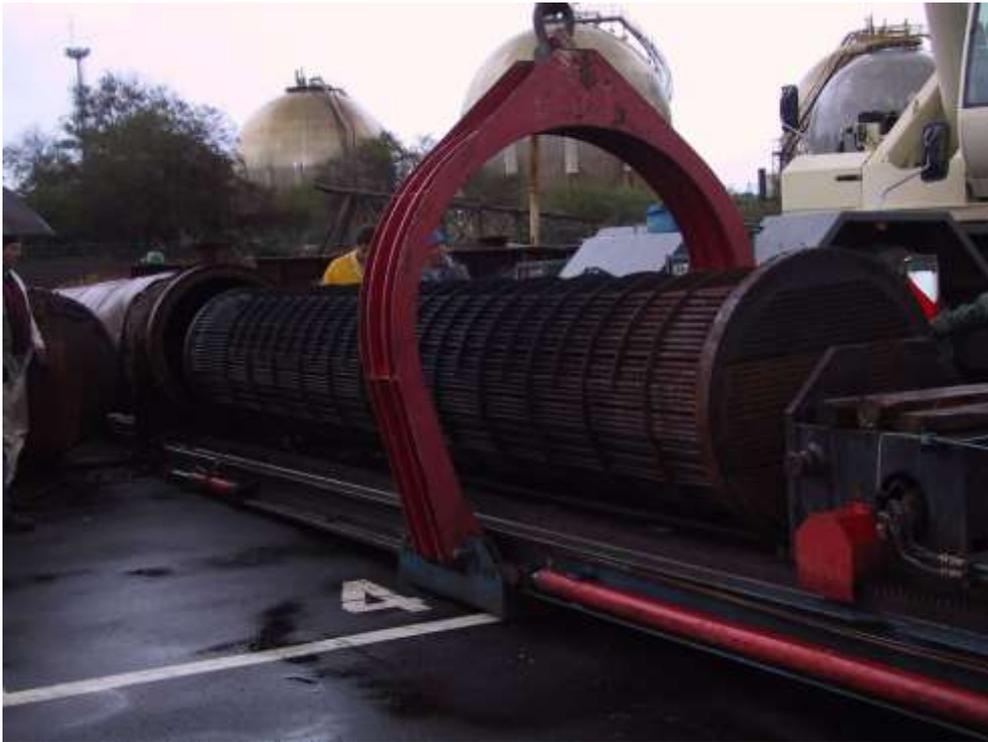
Figura 138: Fascio tubiero estratto da uno scambiatore di calore
