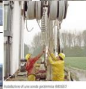
Installazione di una sonda geotermica RALXEO
