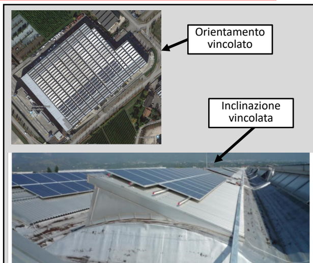
► Figura 5.18 Esempio di impianto fotovoltaico su shed di un edificio industriale. L'orientamento dei pannelli è vincolato dalla disposizione dell'edificio, l'angolo di tilt è vincolato dalla configurazione in sezione degli shed che realizzano la copertura dello stabilimento. 58
