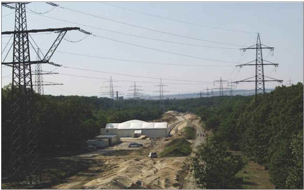
Figura 9 Vista delle linee aeree che interferivano con l'aeroporto di Francoforte e area mobile per l'assemblaggio del GIL (Germania 2010).
