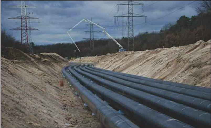
Figura 11 Primo GIL direttamente interrato al mondo di seconda generazione (prima di essere interrato).
