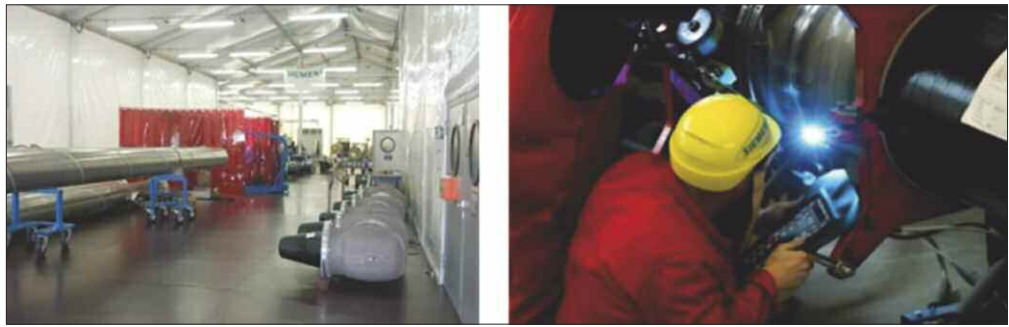
Figura 10 Area mobile e a dx operazioni di saldatura.
