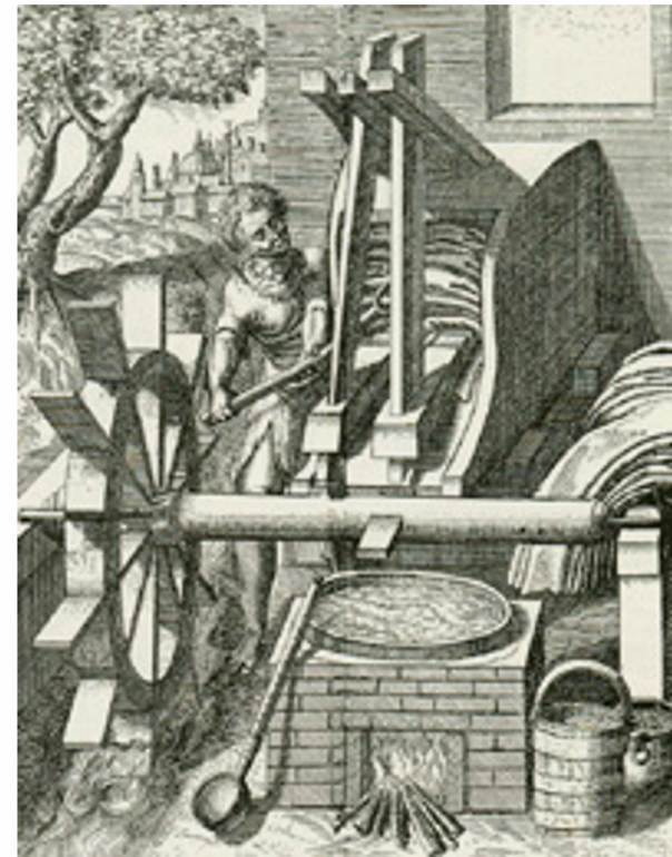
Ruota per di sotto per follatura - Strada - 1617
