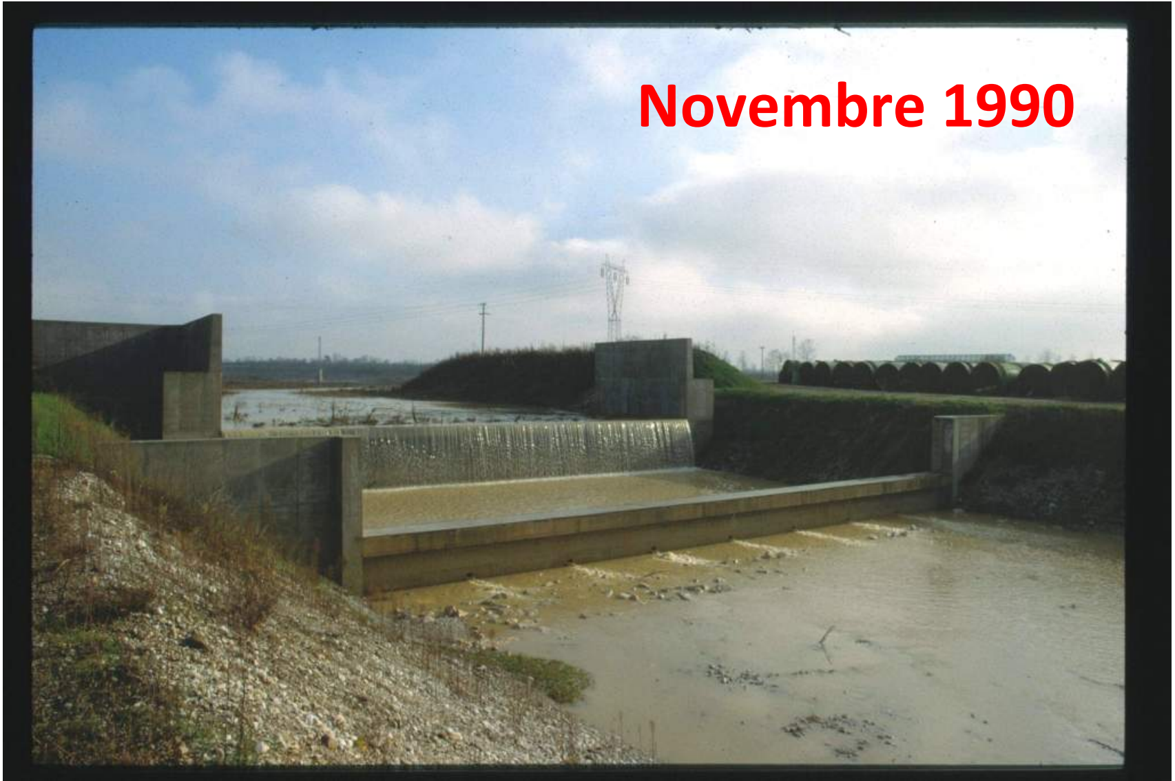
Uscita dalla cassa di espansione del torrente Artugna (PN)
