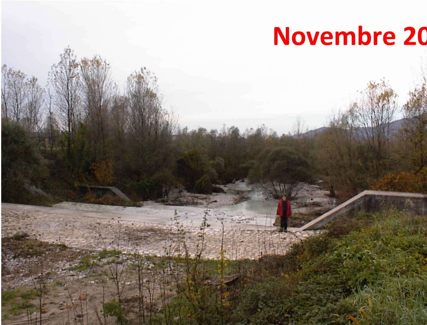
Ingresso alla cassa di espansione del torrente Artugna (PN)
