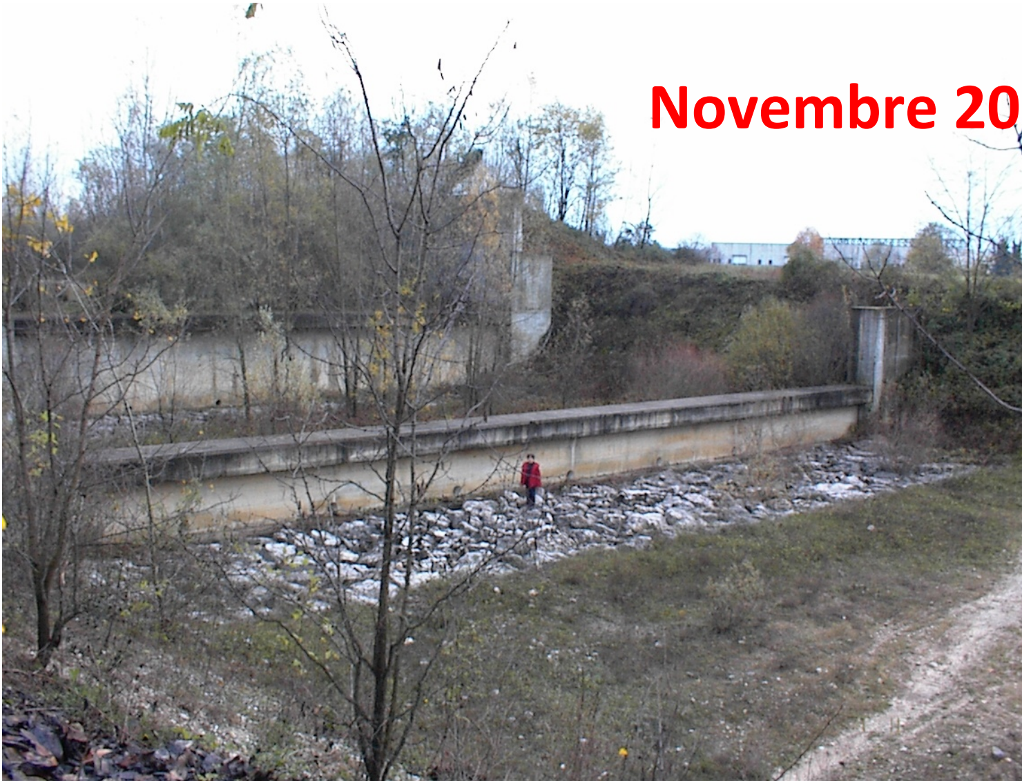
Uscita dalla cassa di espansione del torrente Artugna (PN)
