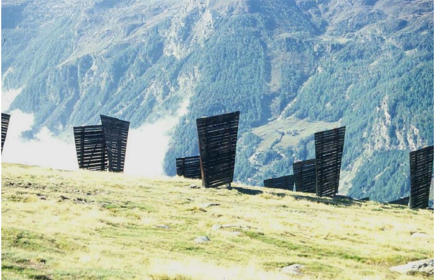
Deflettori del vento – Madesimo (SO)
