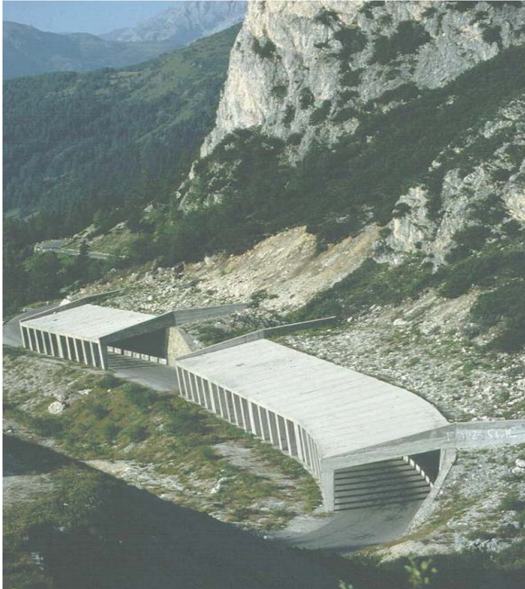
Galleria artificiale sulla strada del Passo Falzarego (BL)
